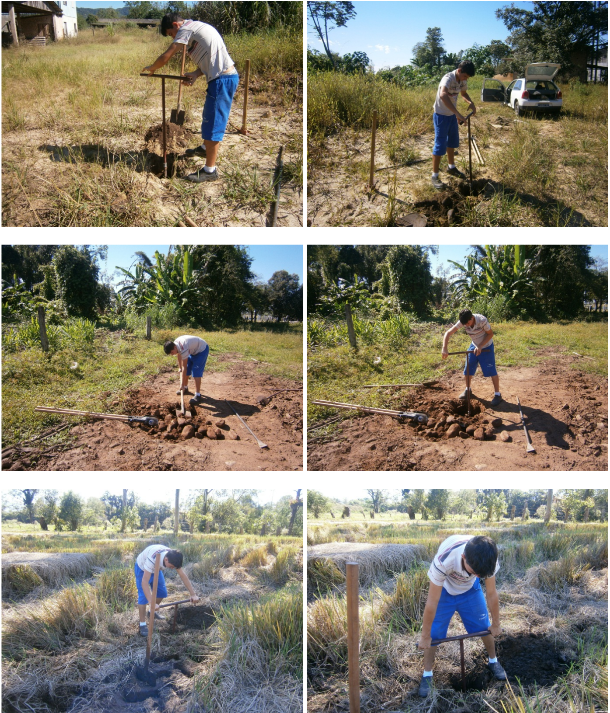
Figura – Investigações geotécnicas
